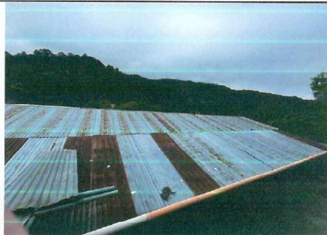
Foto 2: CAMBIO E INSTALACION DE LAMINA POR DETERIORO
